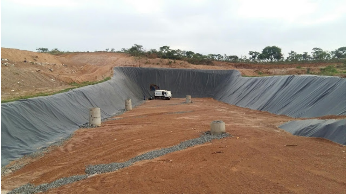
Figura 1-Aterro de Hidrolândia (Goiás) do tipo trincheira
