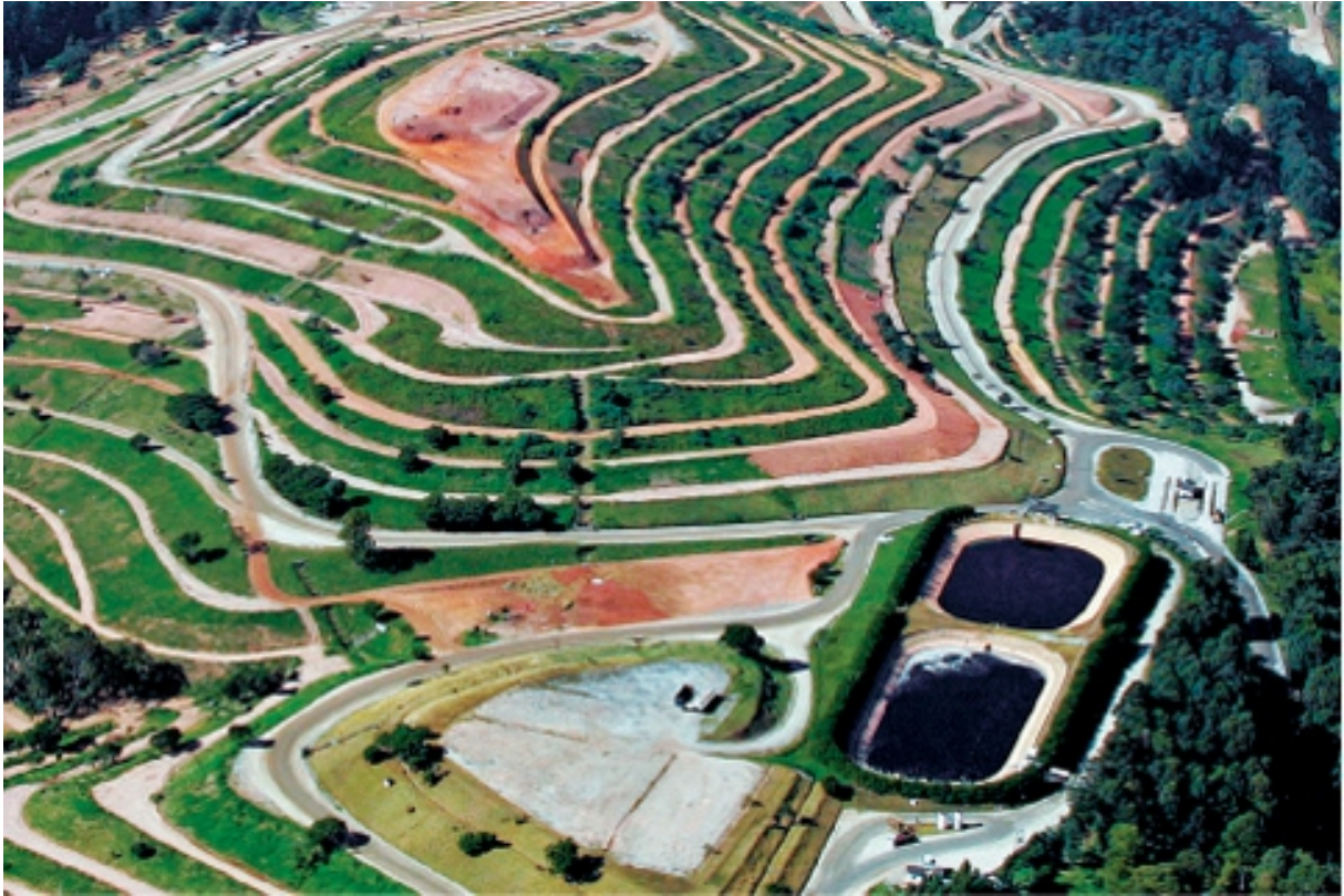
Figura 2- Foto aérea do Aterro Sanitário Bandeirantes – SP
