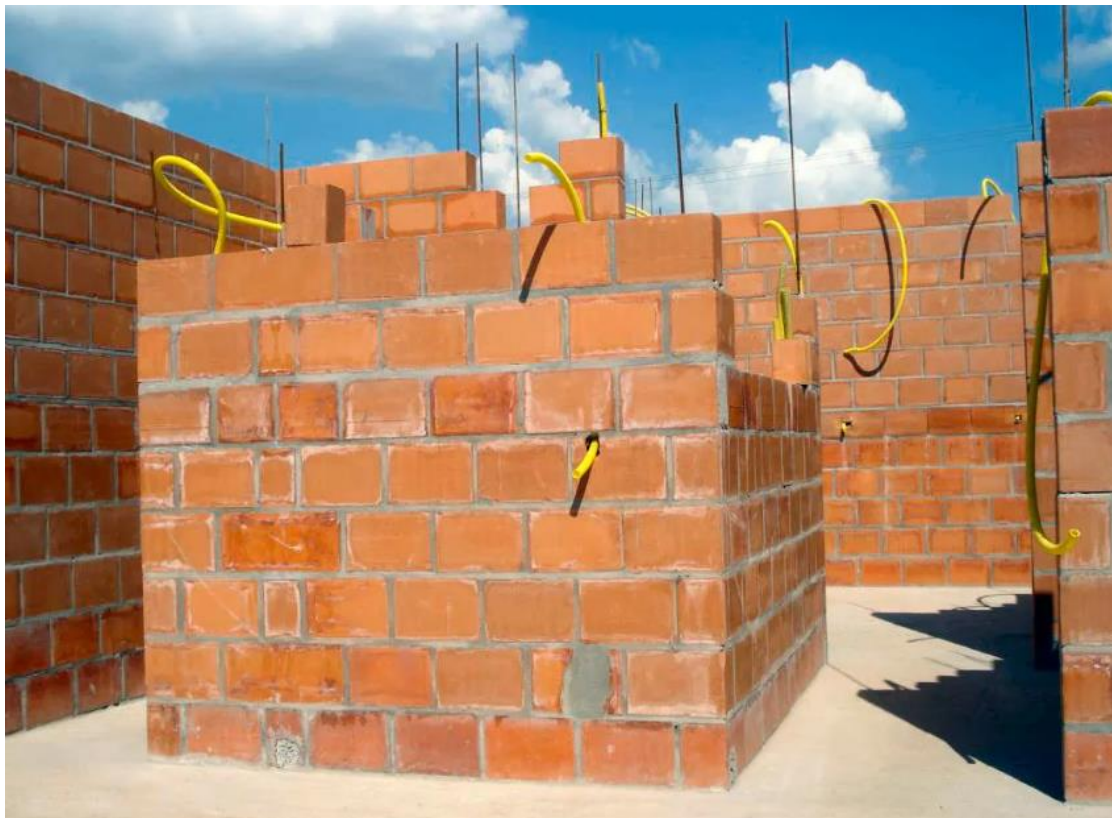
Figura 8. Construção com bloco cerâmico
