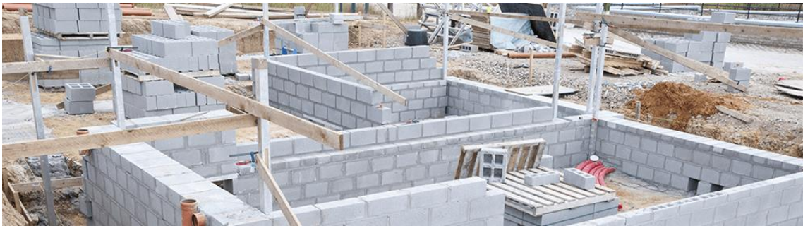
Figura 2. Construção com Bloco de concreto.
