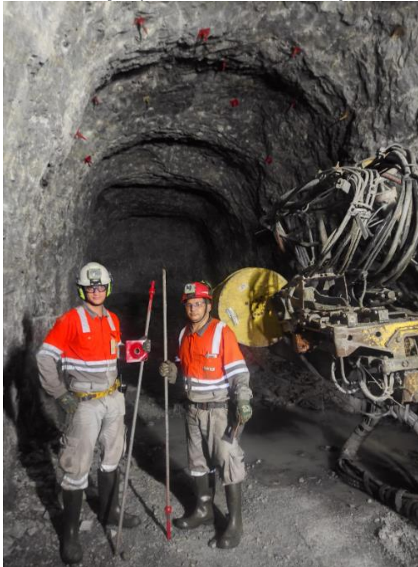
FIGURA 12 - Aplicação de tirante de 1,8 metros na galeria 783-GM2
