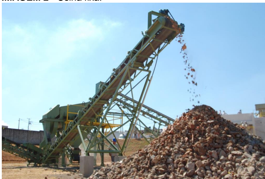
Fonte: Portal resíduos sólidos
