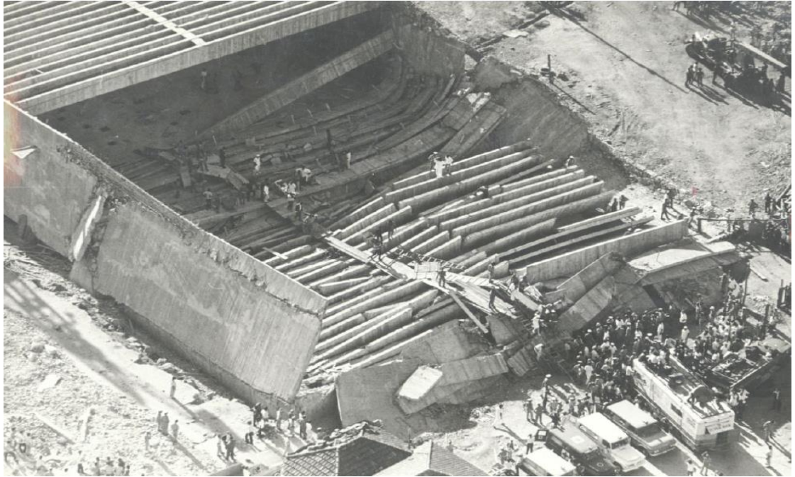
Figura 03: Desmoronamento do pavilhão
