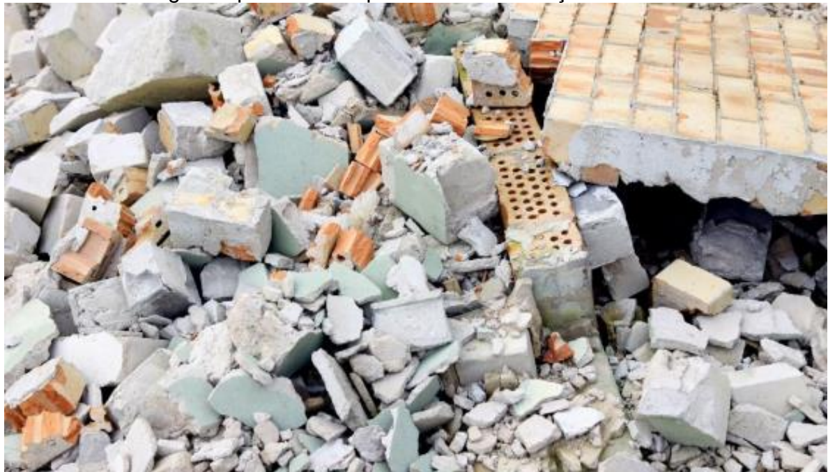
FIGURA 2 - Imagem representa desperdício na construção civil.
