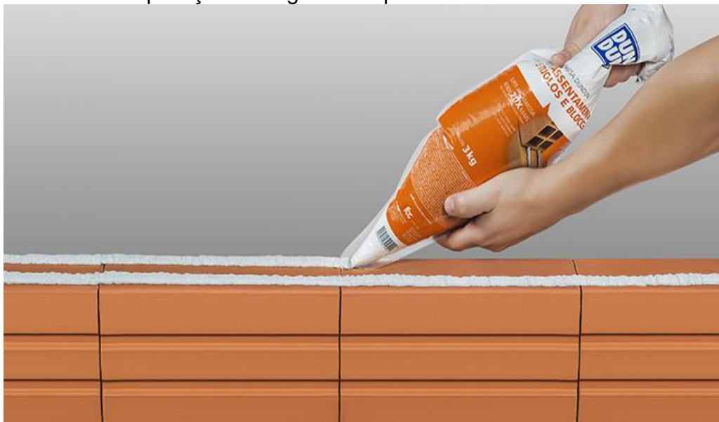
FIGURA 1 – Aplicação de argamassa polimérica
