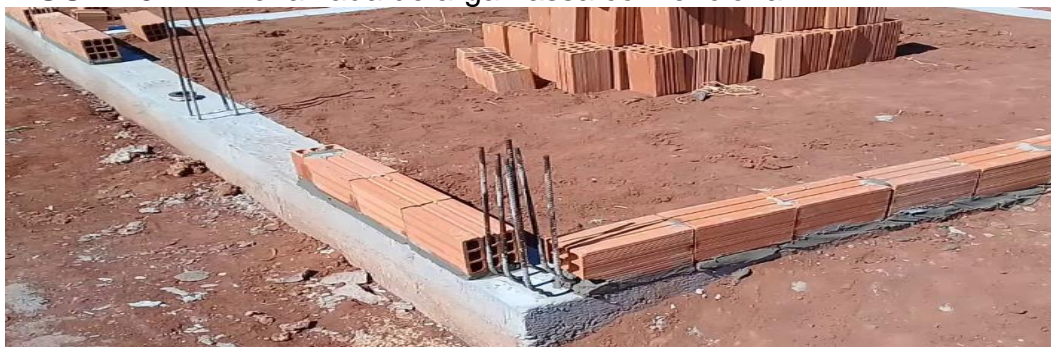
FIGURA 3 - Primeira fiada de argamassa convencional
