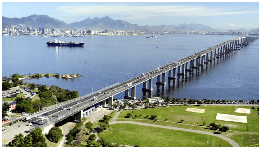
Figura 5: Ponte Rio Niterói
