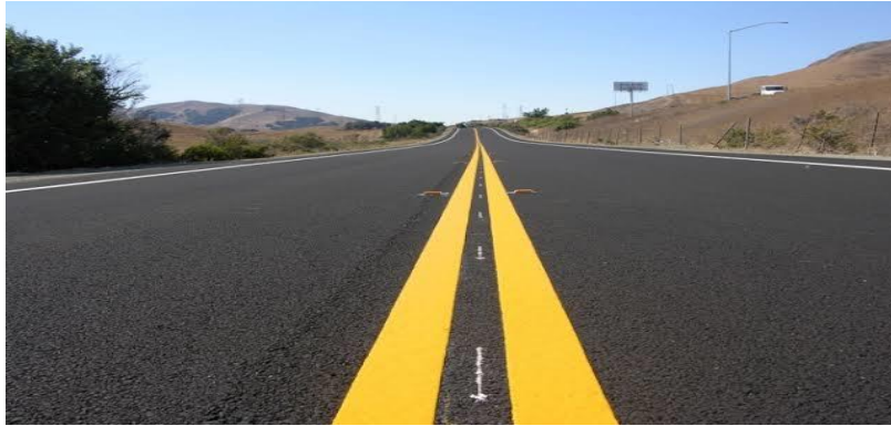
Figura 2: Pavimento Flexível em rodovia.
