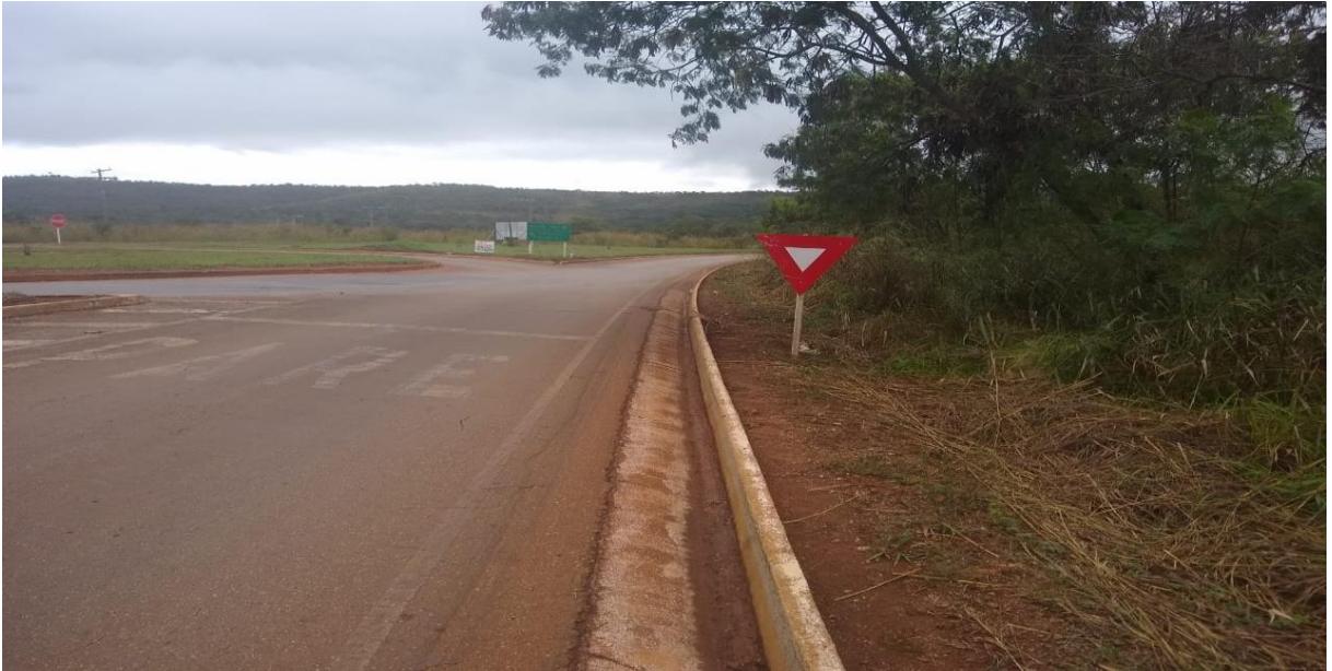
Figura 7 – Falha na sinalização horizontal, placa de sinalização de advertência alocado em local errado (pois ali deveria estar sinal de PARE)
