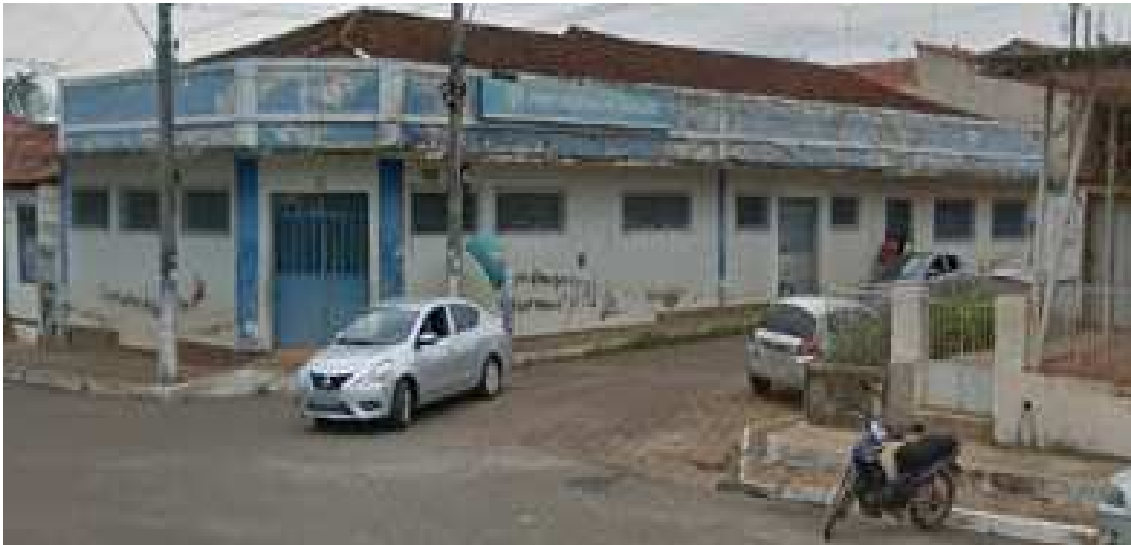
FIGURA 3 -Fachada do imóvel a ser reformado.
