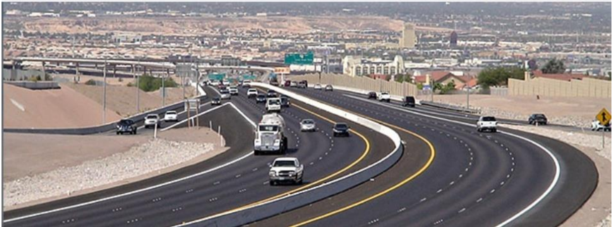
FIGURA 2 – Trecho confeccionado com asfalto-borracha em Las Vegas
