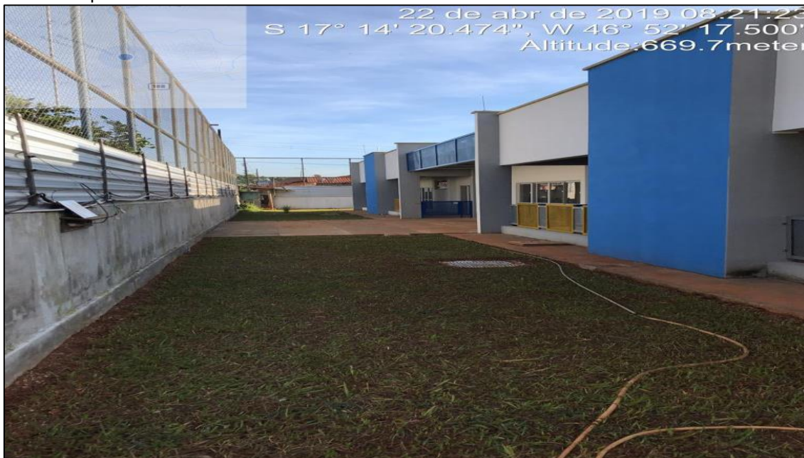
Figura 3 – a pintura da área externa da proinfância tipo II na cidade de Paracatu-MG, construída no bairro Chapadinha ano de 2019
