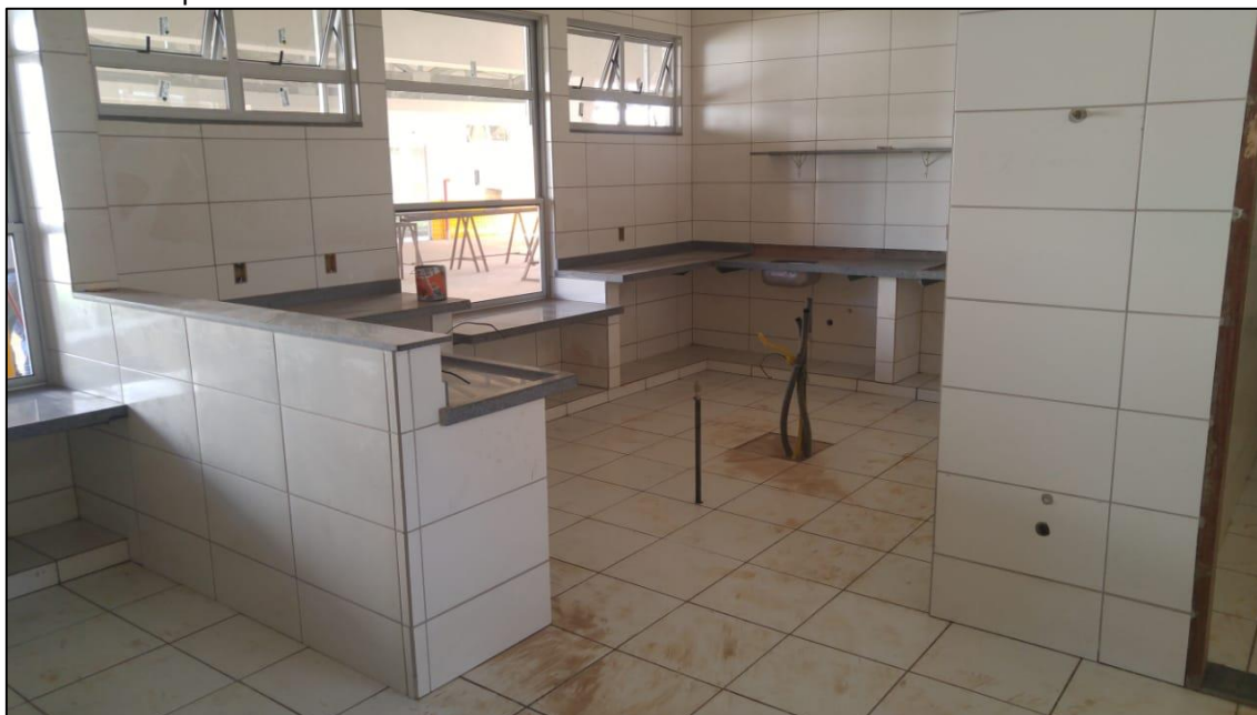
Figura 1- instalação tubo gás fogão industrial na cozinha do proinfância tipo II na cidade Paracatu-MG no bairro Chapadinha ano 2019.
