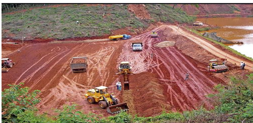
Figura 11 - Compactação de solo jusante (COSTA, 2012)
