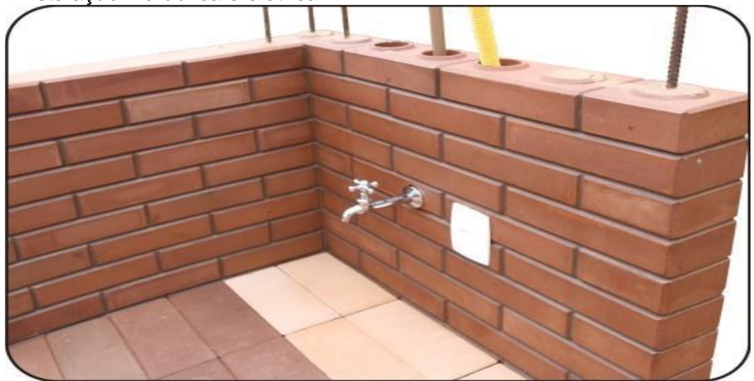
FIGURA 4: instalação hidráulica e elétrica
