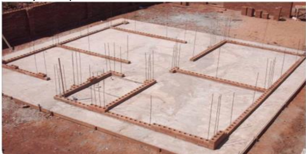
FIGURA 2: Fundação em tijolo solo-cimento
