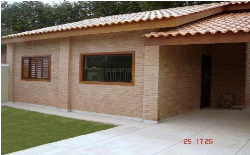
FIGURA 20 – Casa de tijolo de solo-cimento
