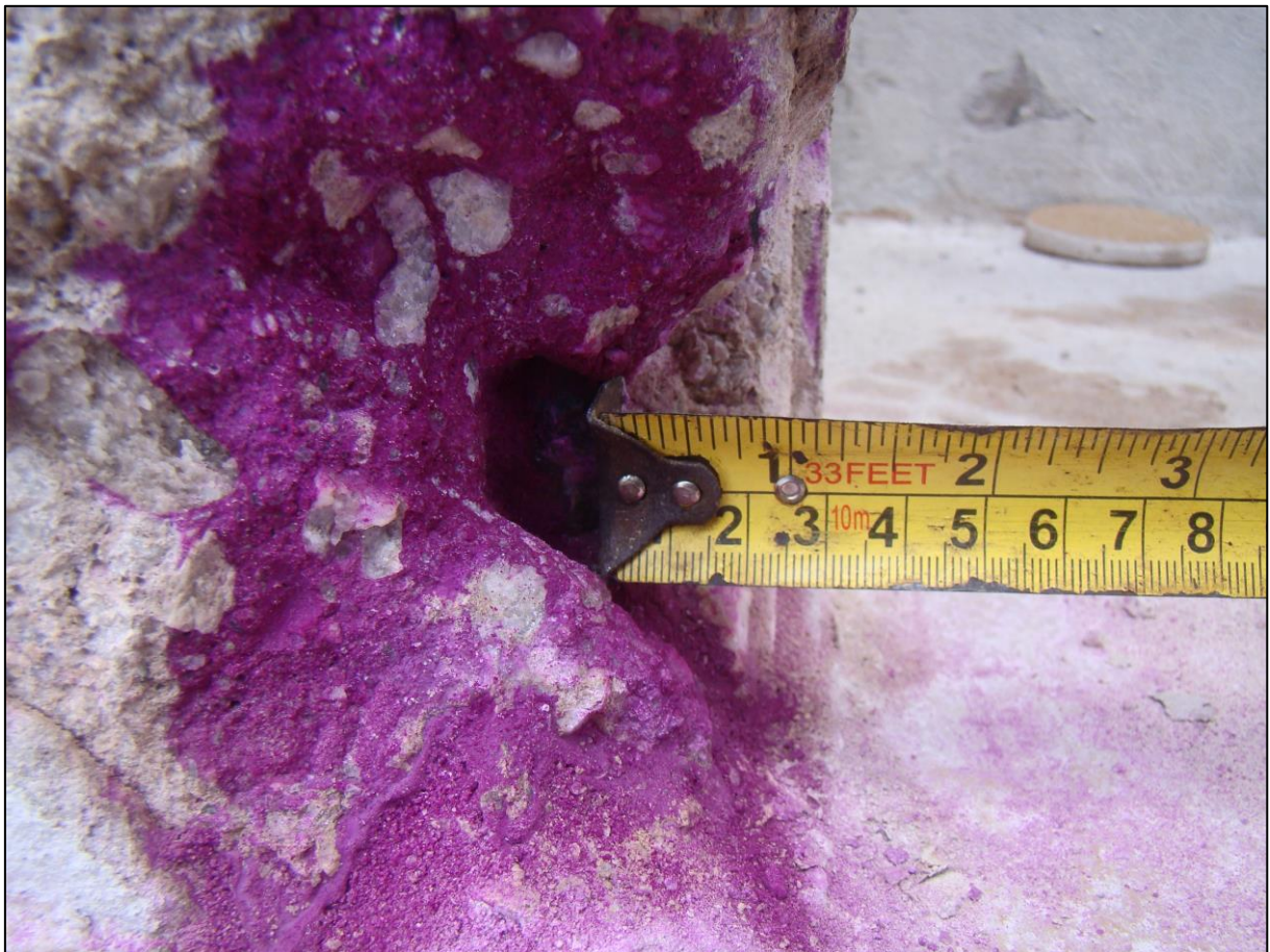
FIGURA 3: Verificação da carbonatação com fenolftaleína.
