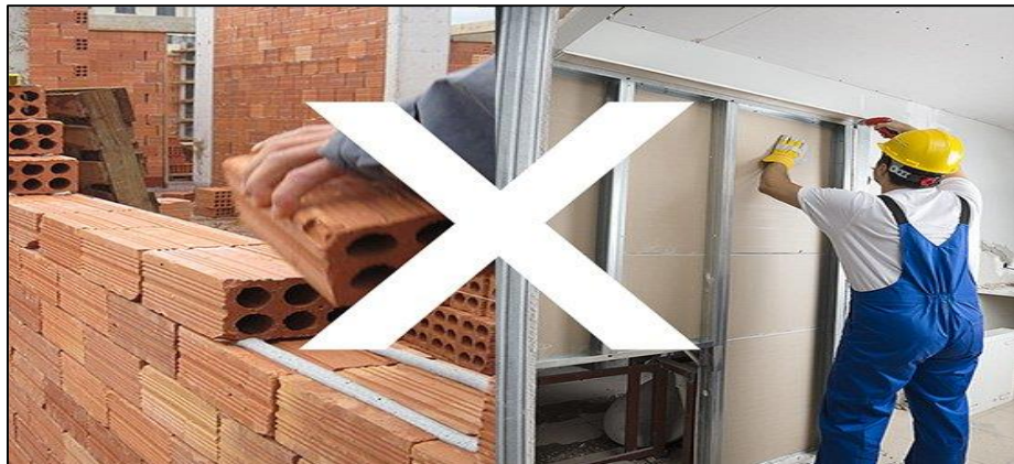
Figura 3 – Execução da vedação interna.
