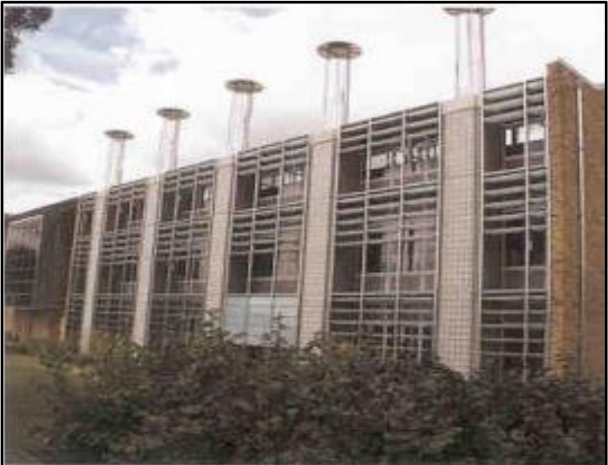
FIGURA 1 – O edifício do meio ambiente do BRE.
