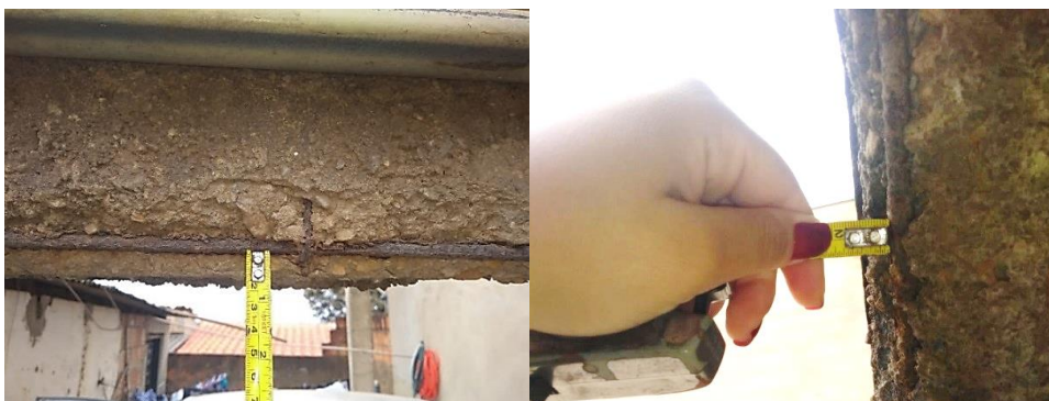
Figura 5 – Medição do cobrimento nominal
