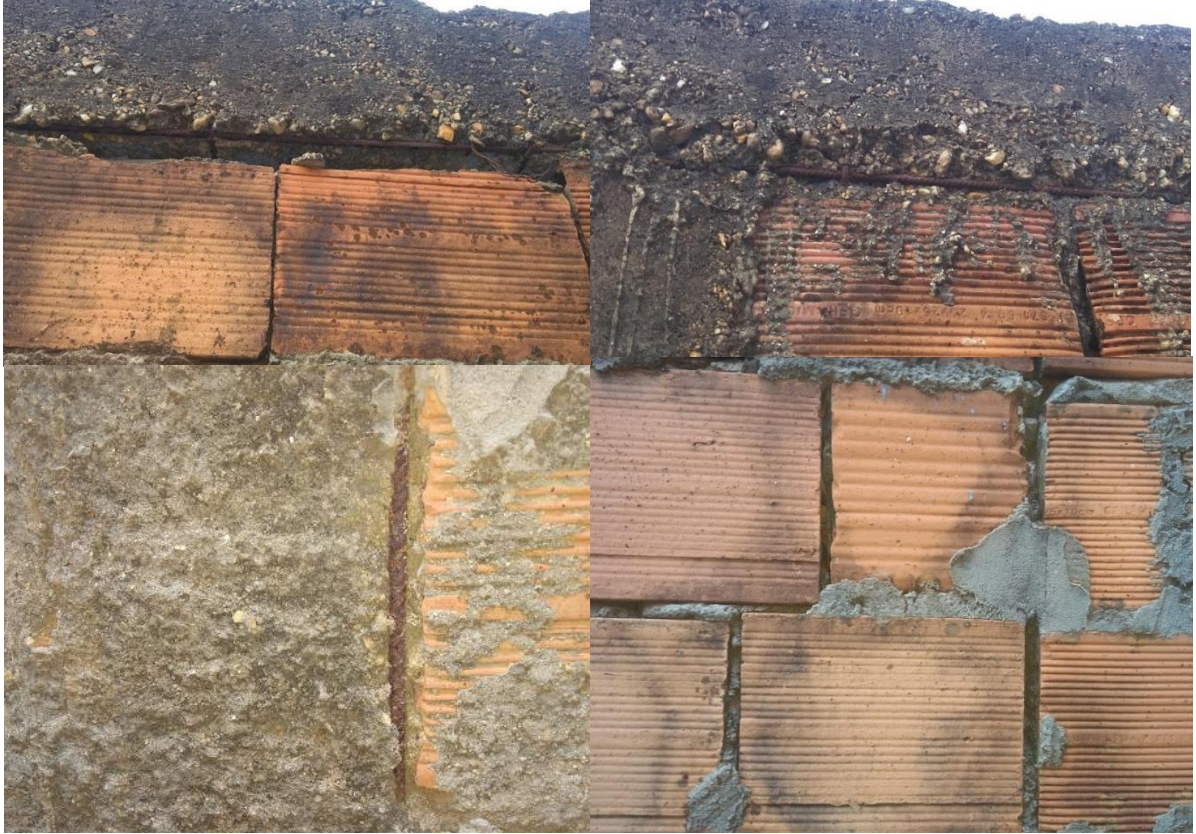
Figura 5 – Detalhes do muro
