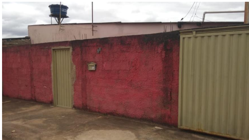
Figura 4 – Fachada da residência
