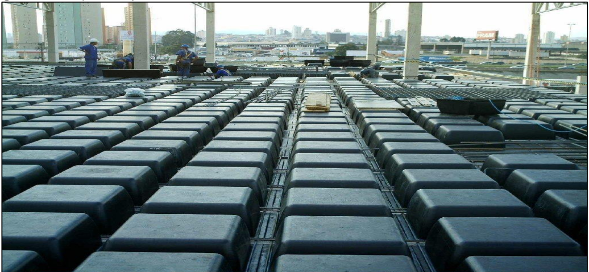
Figura 2- Exemplo de laje nervurada.
