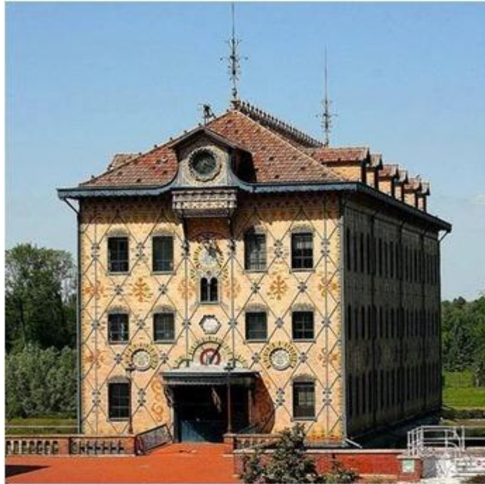
Figura 2: Primeiras construções construídas utilizando aço
