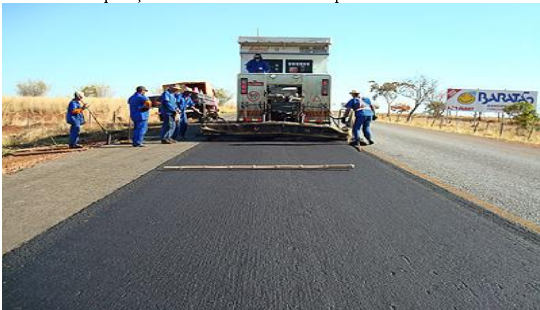
FIGURA 3 – Aplicação de microrrevestimento no pavimento.
