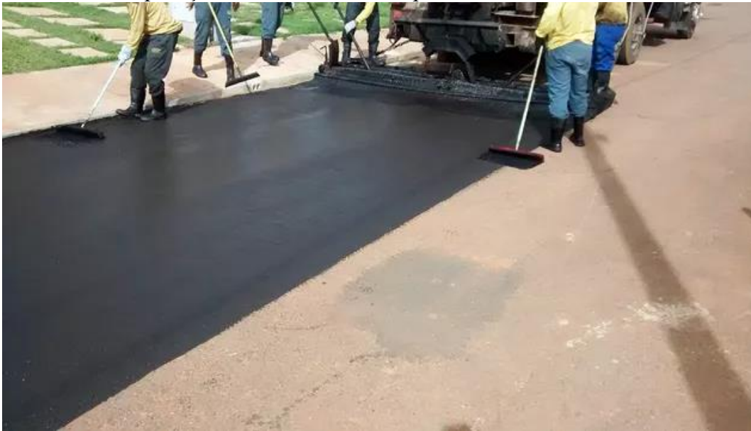
FIGURA 4 – Aplicação de lama asfáltica no pavimento.
