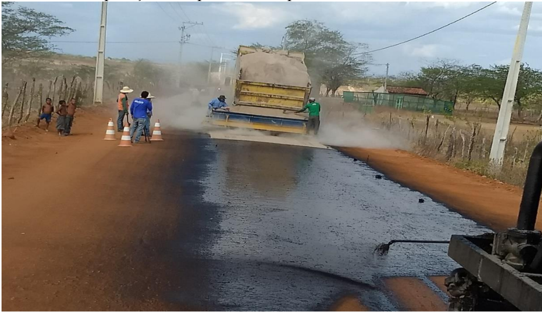
FIGURA 2 – Aplicação de capa selante no pavimento.
