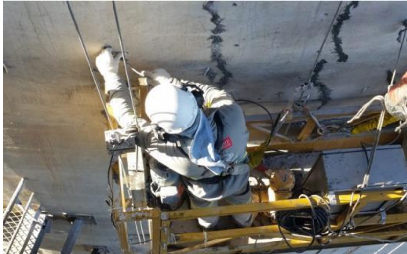
FIGURA 10 - Aplicação da resina epóxi
