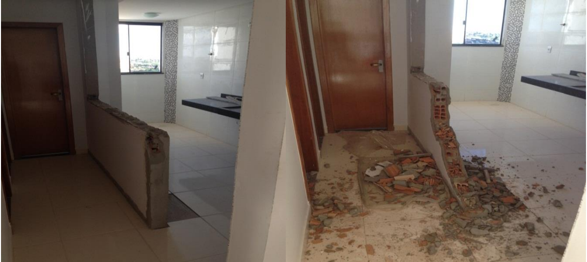
FIGURA 2: Perda segundo a fase do empreendimento quebra da parede preferência do cliente.
