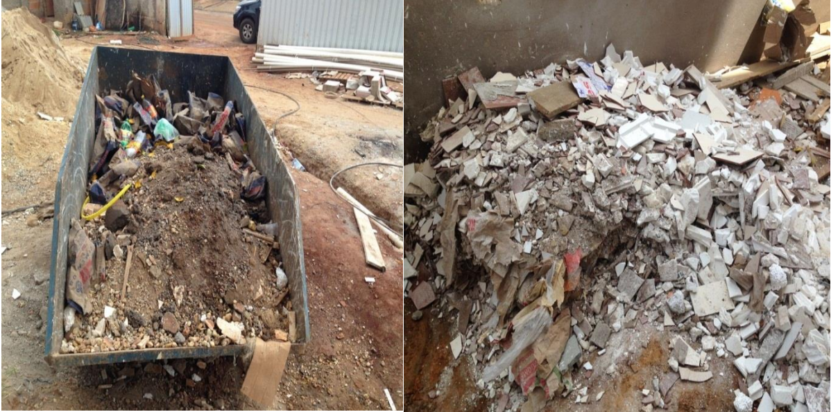
FIGURA 4: Perdas segundo sua natureza o entulho produzido na construção.
