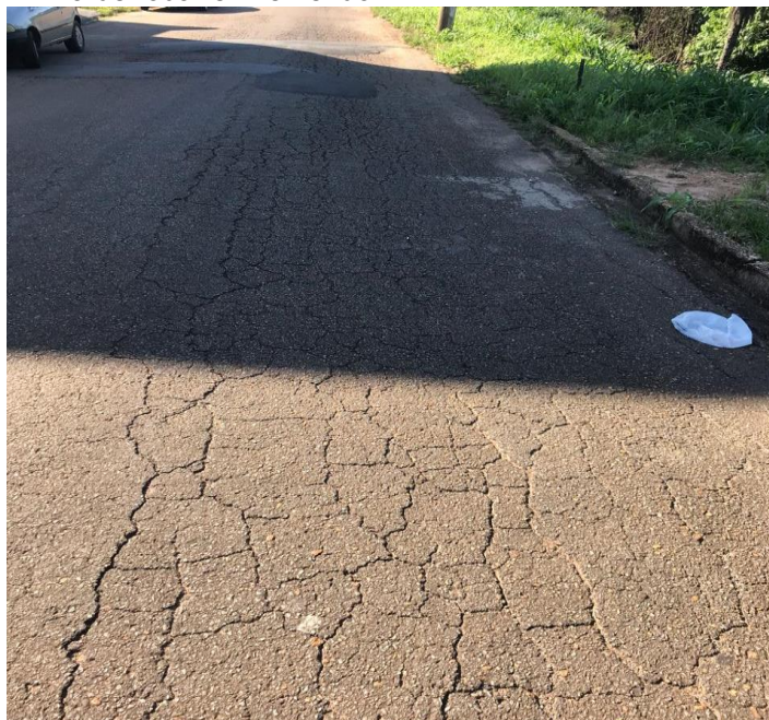
FIGURA 4 – Patologias do tipo “Couro de Jacaré”, “Desgaste”, “Trilha de roda” e “Remendo”.
