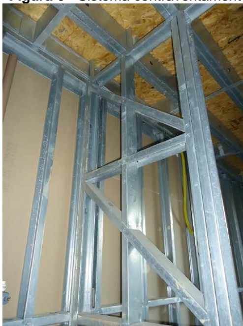
Figura 6 - Sistema contraventamento em K.
