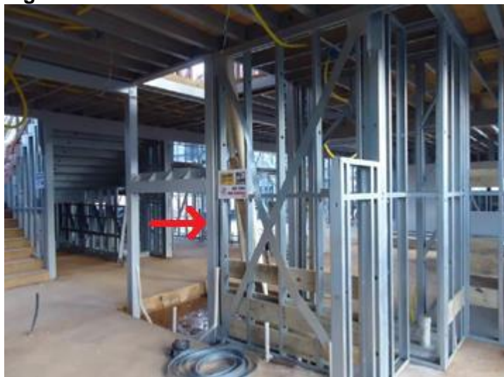
Figura 5 - Sistema contraventamento em X.
