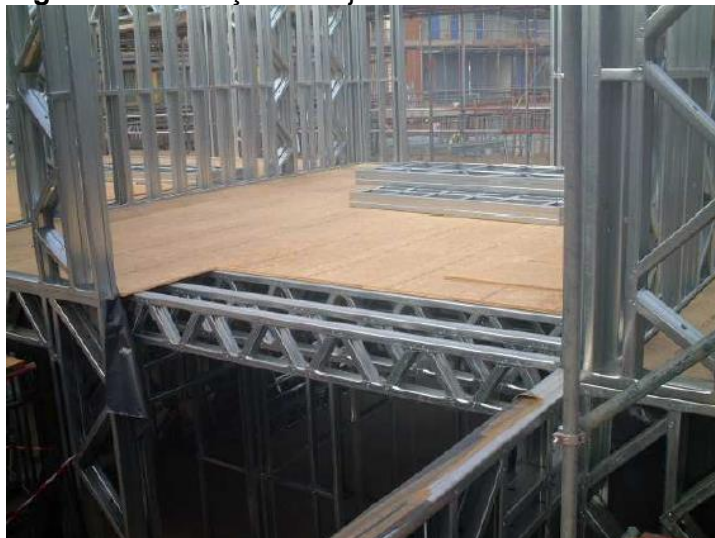
Figura 8 - Execução da laje em OSB.
