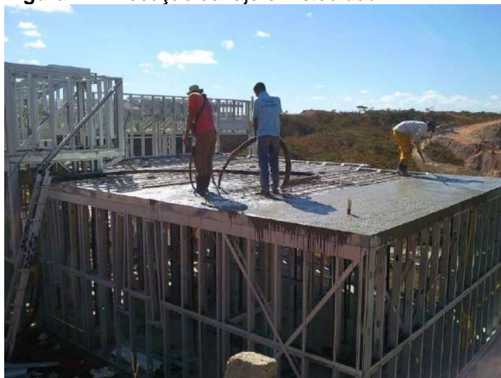
Figura 7 - Execução da laje em steeldeck .
