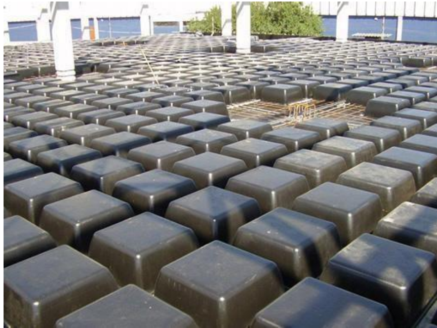
FIGURA 10 - Formas de polipropileno na laje nervurada.
