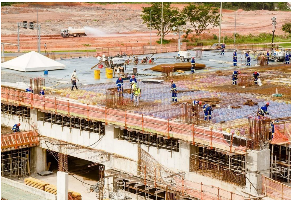
FIGURA 5 – Centro Administrativo do Distrito Federal.
