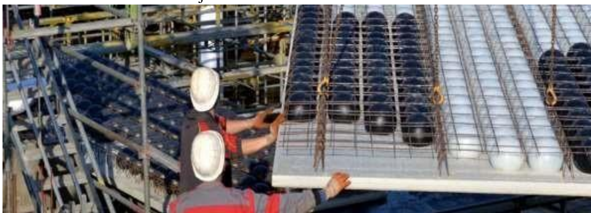
FIGURA 8 - Painel de Pré-lajes
