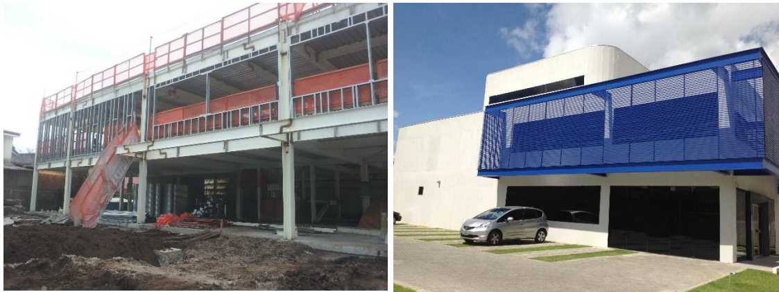
FIGURA 7- Fechamento de fachada em LSF da Caixa Econômica Federal
