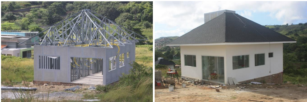
FIGURA 5- Casa residencial em LSF
