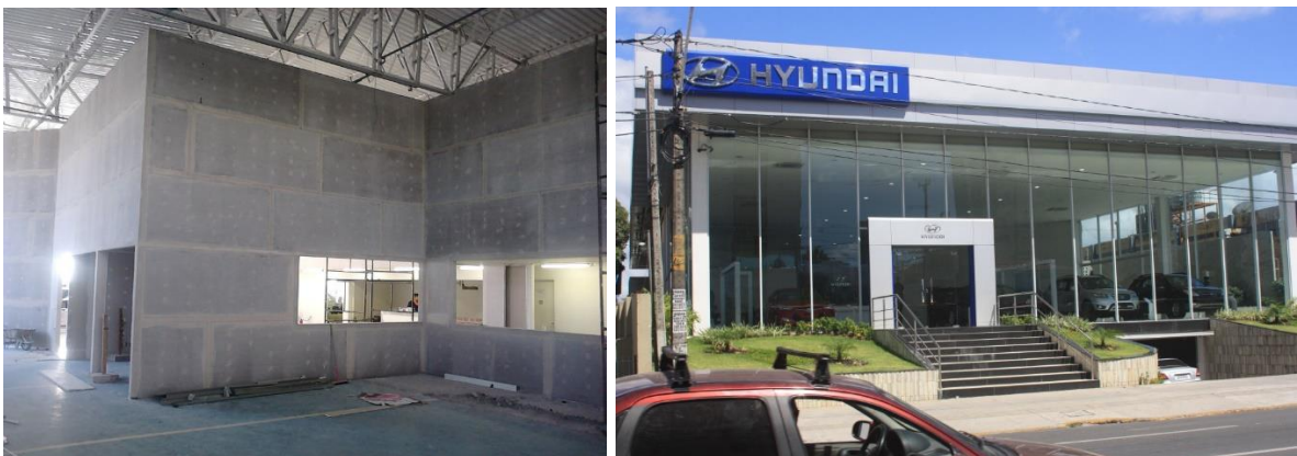
FIGURA 6- Edificação comercial em LSF
