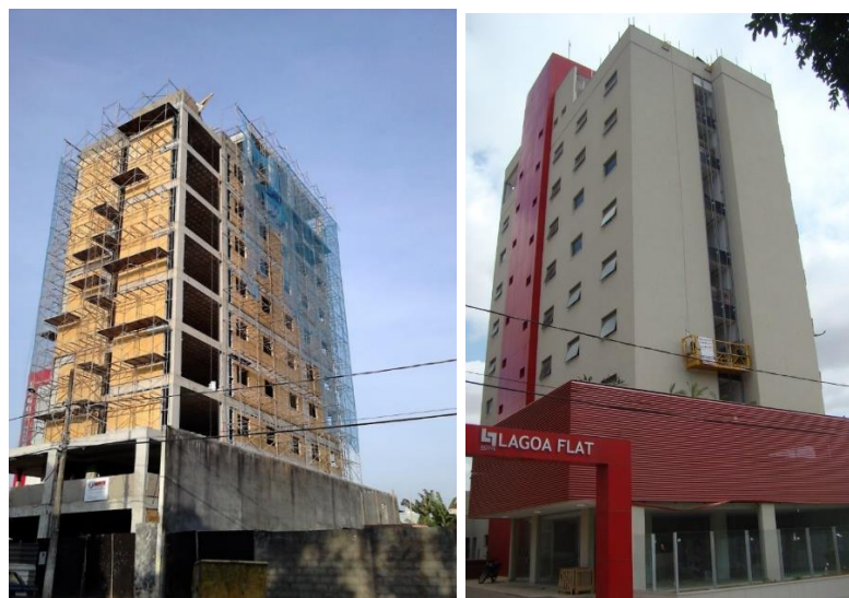
FIGURA 8- Fachada de edifício em LSF
