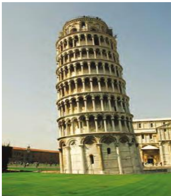
FIGURA 1 – Recalque presente na Torre de Pisa.
