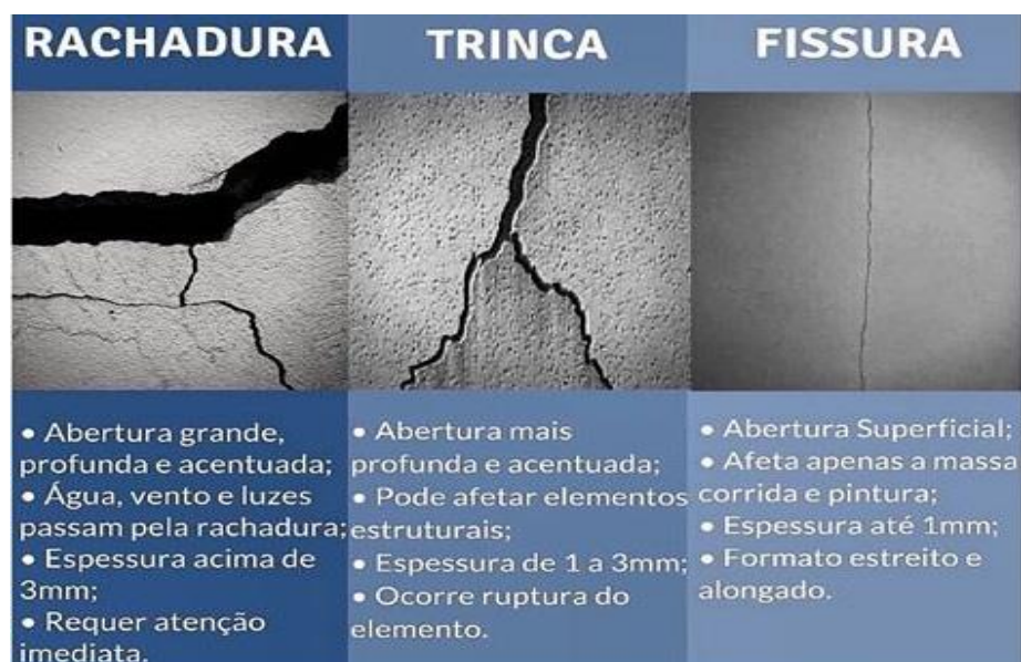
FIGURA 4 – Fissuras, trincas e rachaduras.
