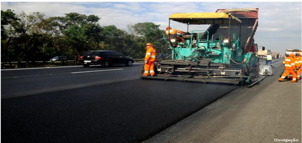
FIGURA 11 – Processo de aplicação asfalto borracha
