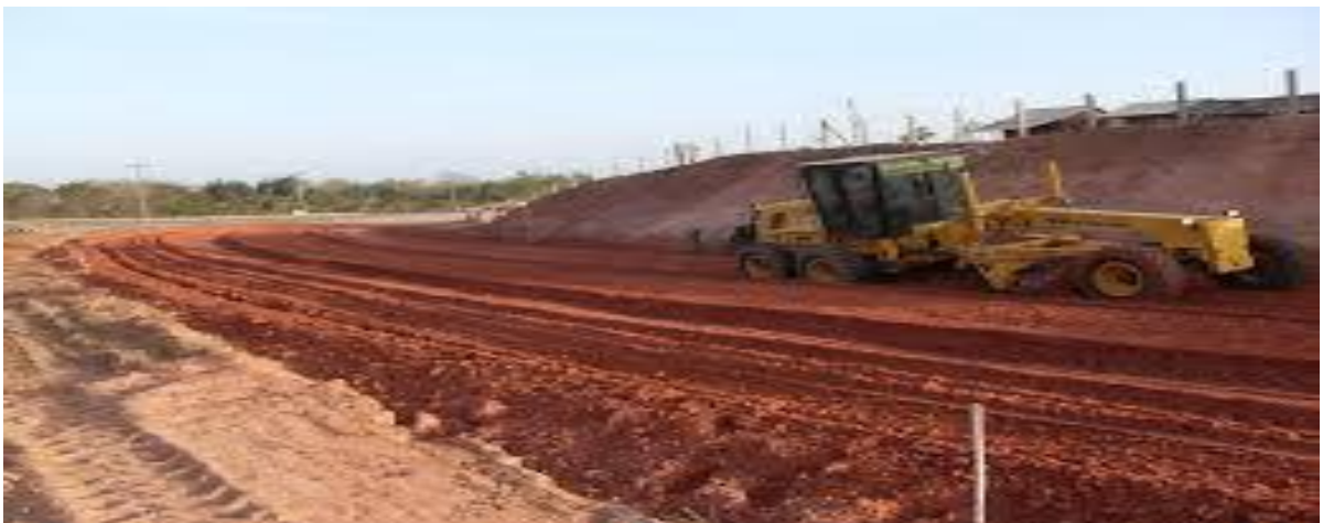
Figura 6: Regularização do subleito
