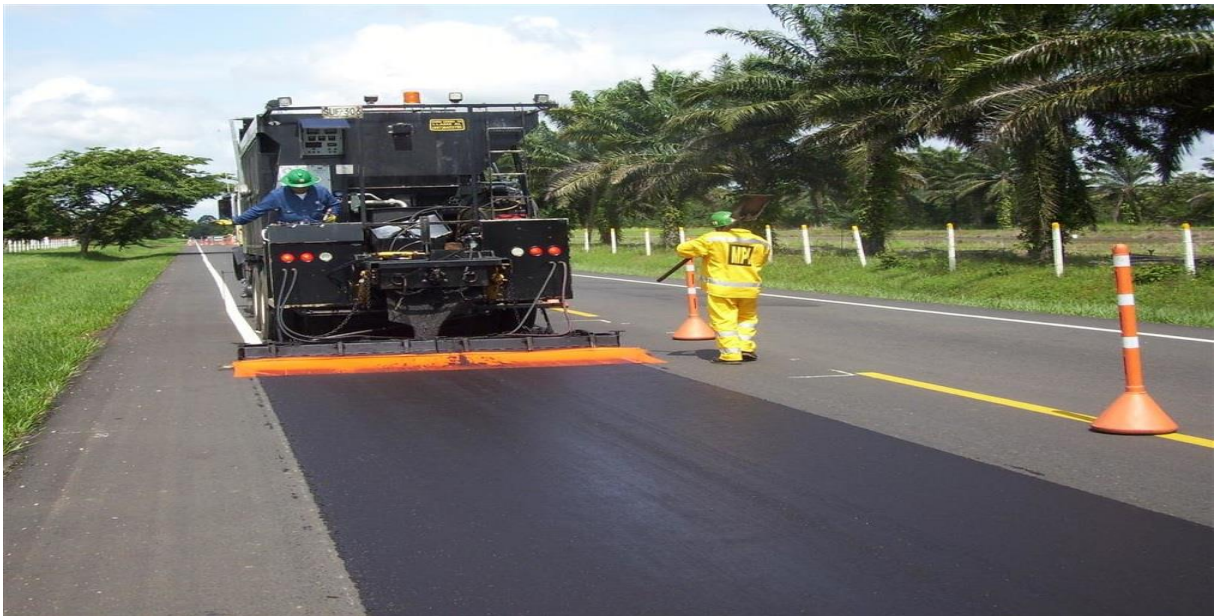
FIGURA 9 – Pavimento recebendo prevenção com Micro Revestimento.
