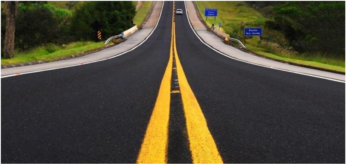
FIGURA 12 – Pavimento utilizando asfalto borracha
