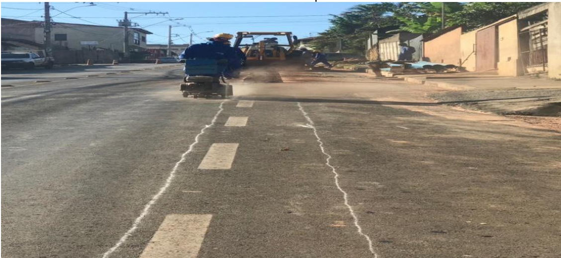
FIGURA 6 - Corte do pavimento
