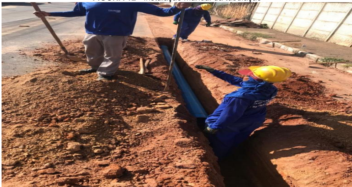
FIGURA 12 - Instalação manual da tubulação
