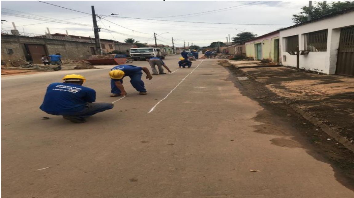
FIGURA 5 - Marcação das dimensões da vala
