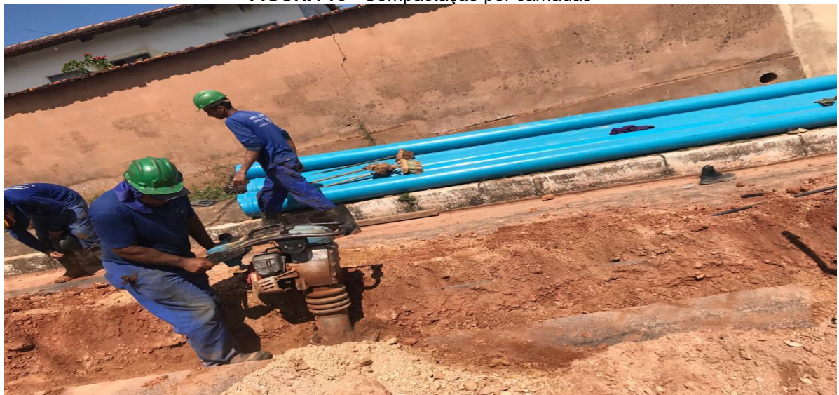
FIGURA 16 - Compactação por camadas
