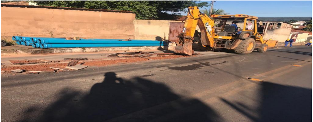
FIGURA 7 - Retira do pavimento
