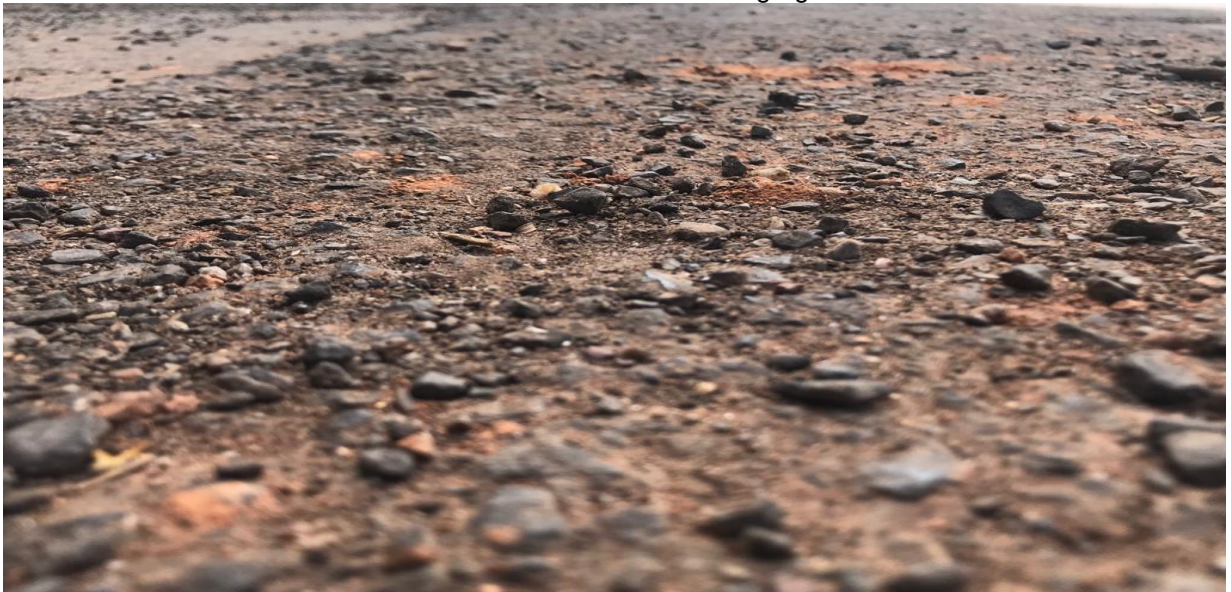
FIGURA 26 - Descolamento dos agregados
