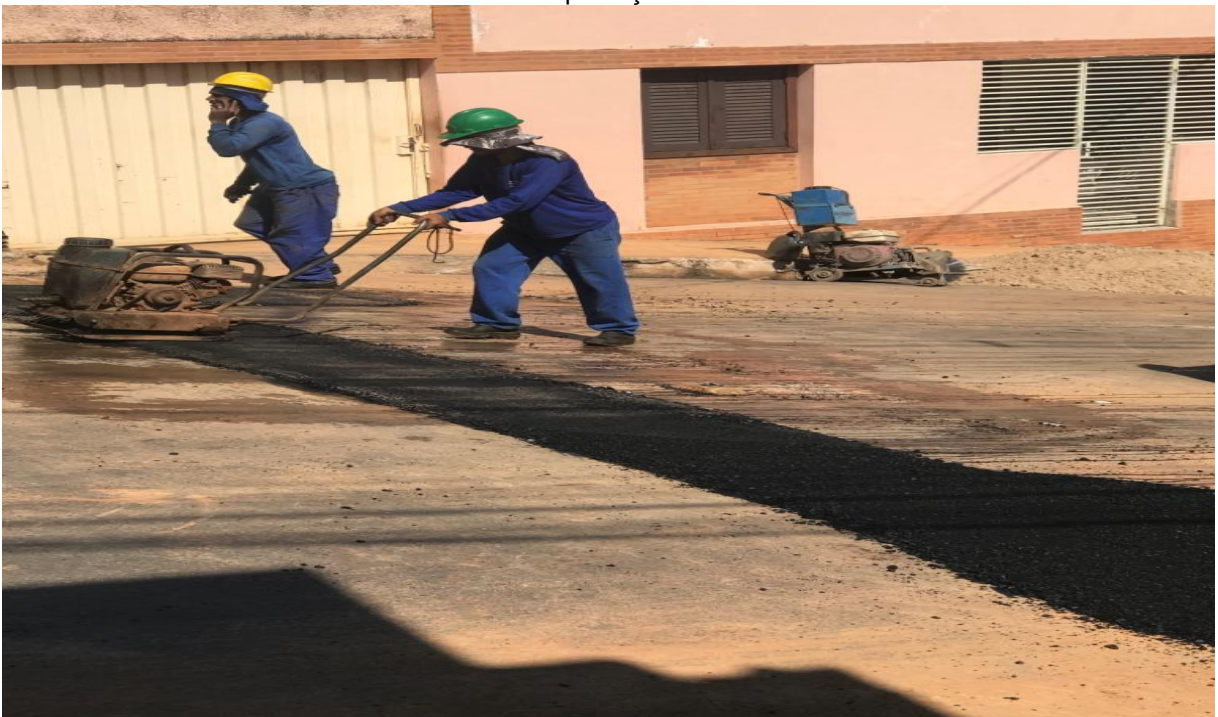
FIGURA 20 - Compactação do revestimento
