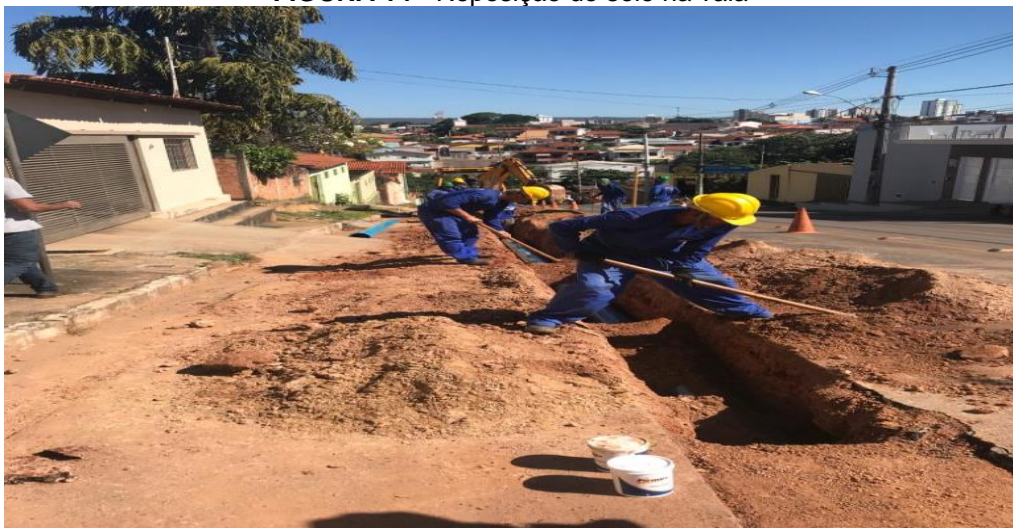
FIGURA 14 - Reposição do solo na vala
