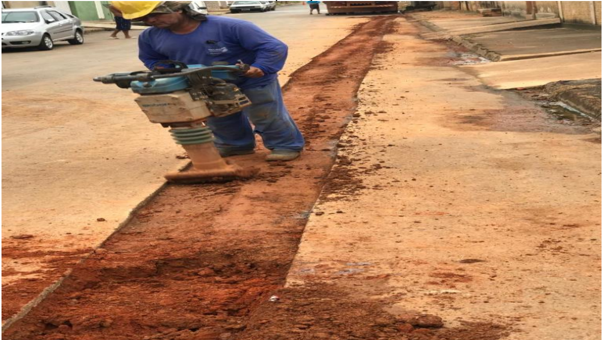
FIGURA 17 - Compactação da última camada
