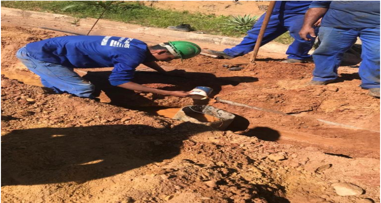
FIGURA 11 - Retirada da água
