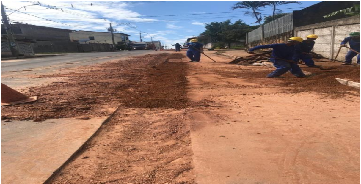
FIGURA 15 - Camada de cascalho
