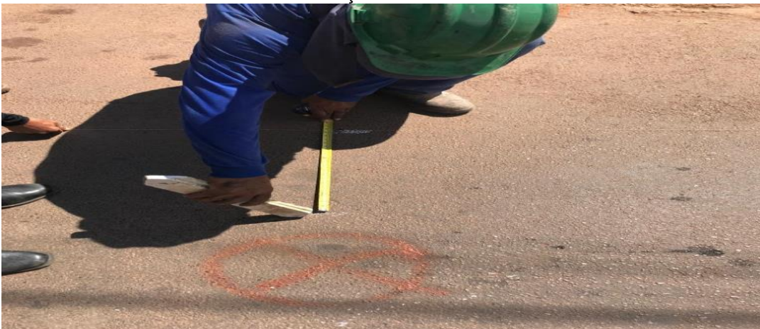
FIGURA 4 - Marcação das dimensões da vala
