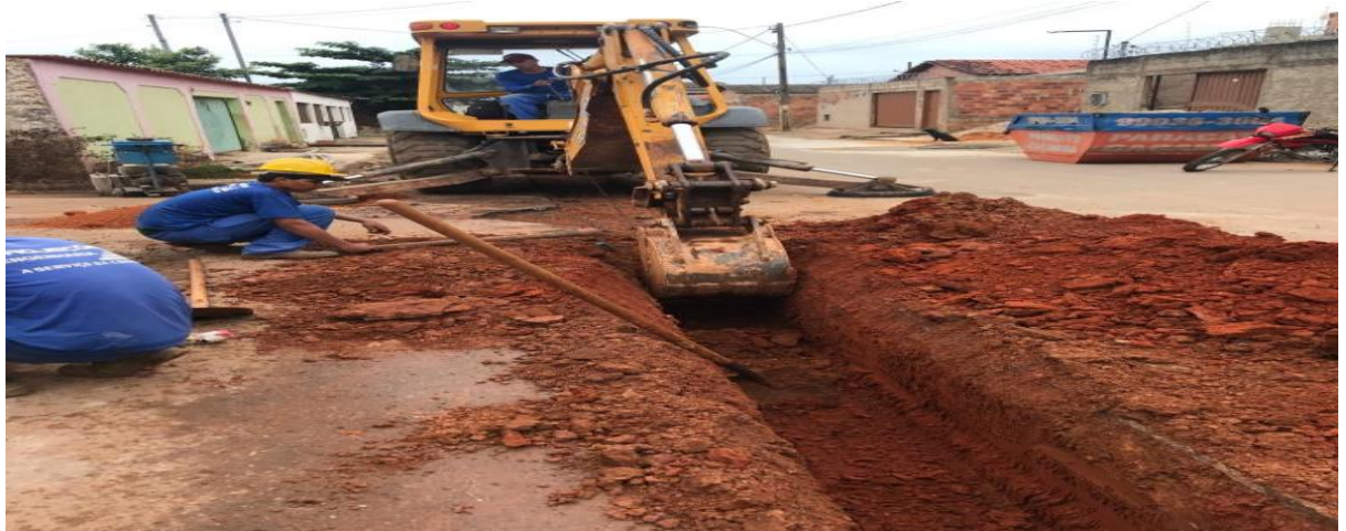
FIGURA 8 - Retirada do solo de forma mecânica
