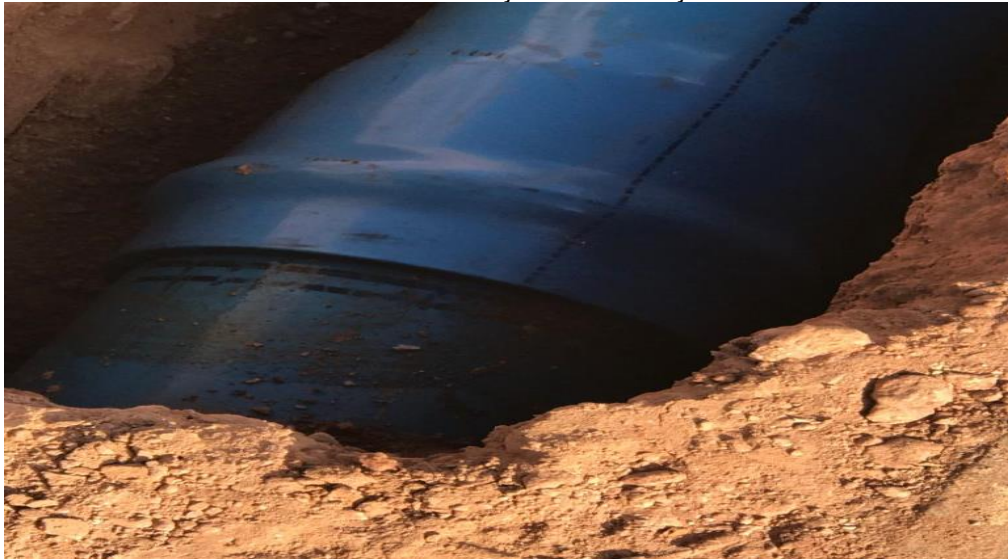
FIGURA 13 - Junção das tubulações
