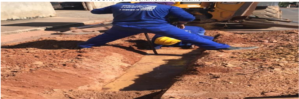
FIGURA 10 - Fechamento do vazamento
