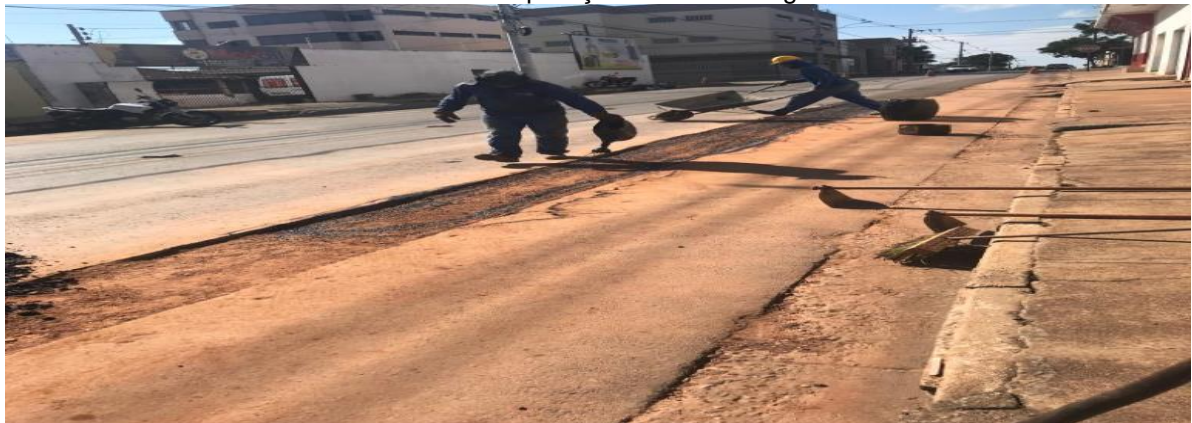
FIGURA 18 - Aplicação do material ligante
