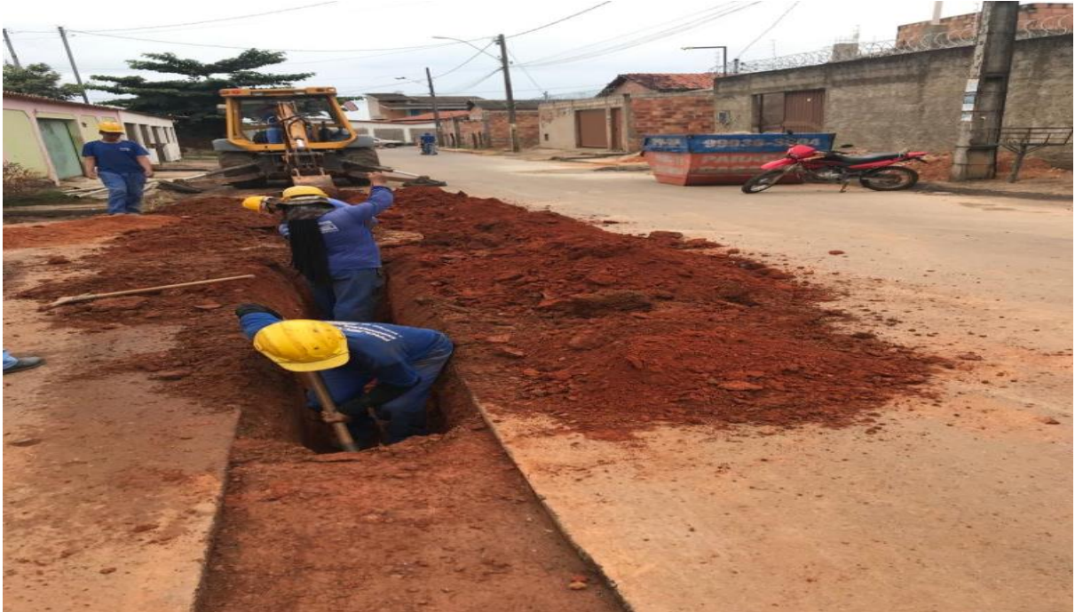
FIGURA 9 - Retirada do solo de forma manual
