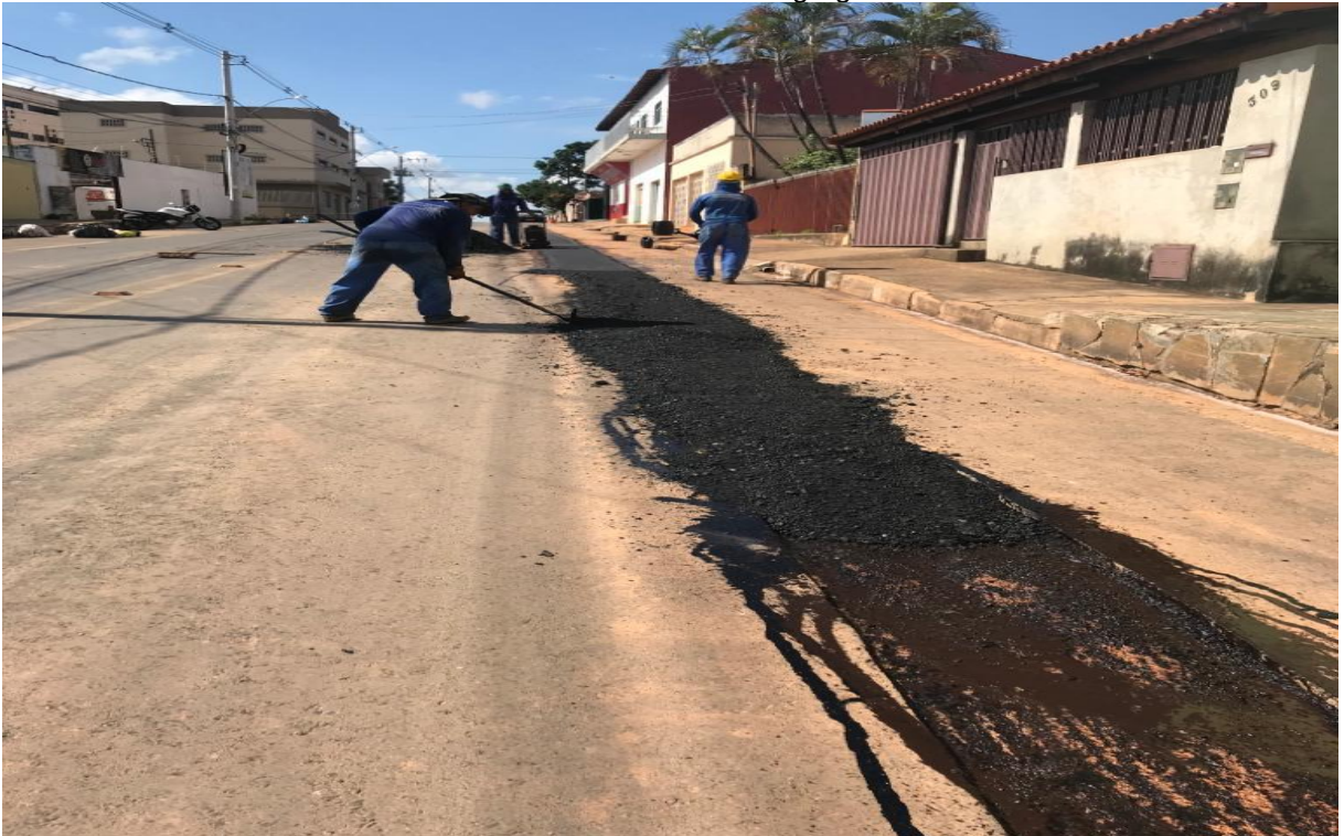
FIGURA 19 - Posicionamento dos agregados na vala
