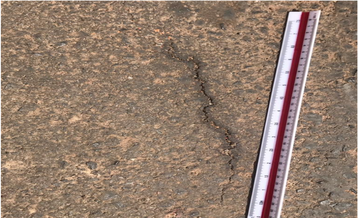
FIGURA 23 - Trinca transversal
