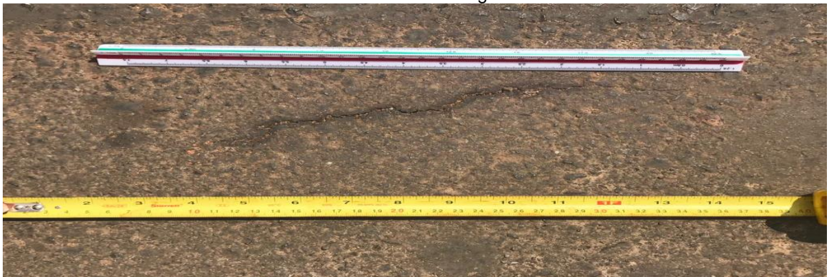
FIGURA 22 - Trinca longitudinal
