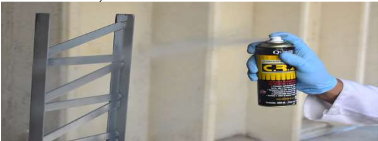
FIGURA 7 – Galvanização a frio.
