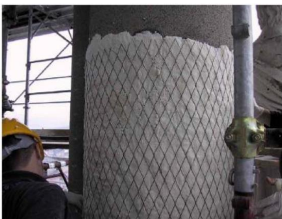
FIGURA 4 - Aplicação do sistema anódico sobre a estrutura para início da ERA
