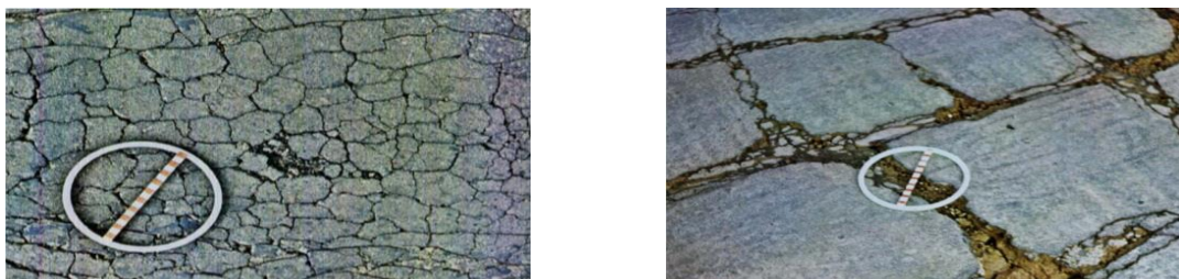
Figura 4 – Trinça interligada tipo jacaré e tipo bloco.
