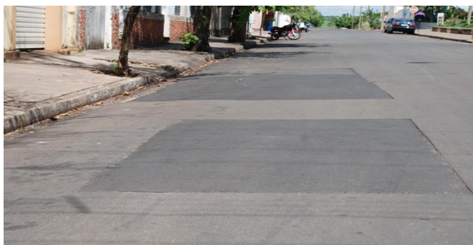
Figura 11 – Remendo.
