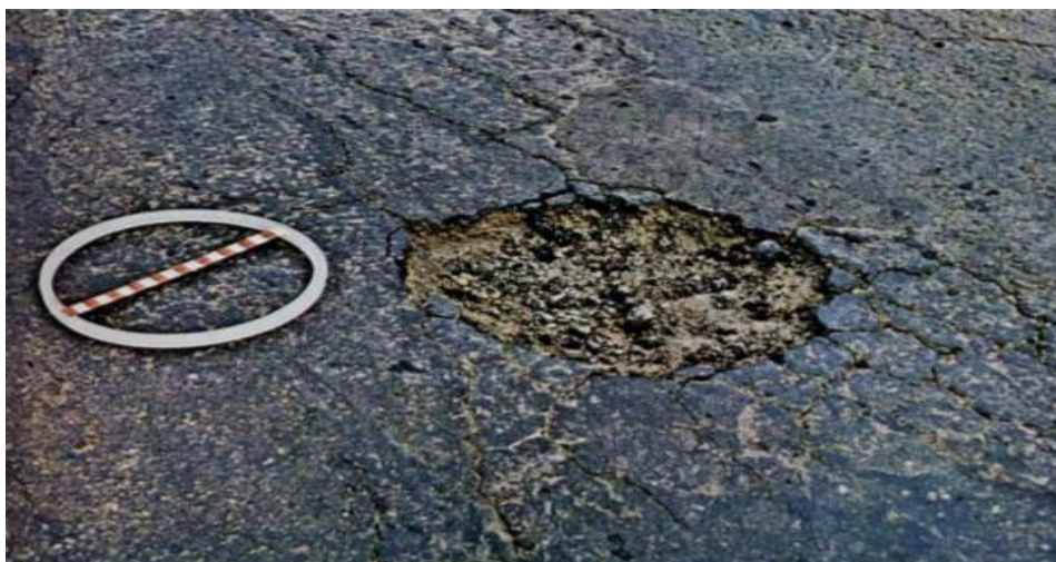
Figura 10 – Painela/buraco.
