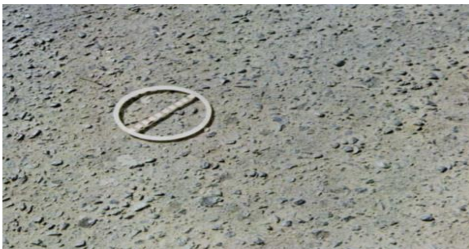
Figura 9 – Desgaste.
