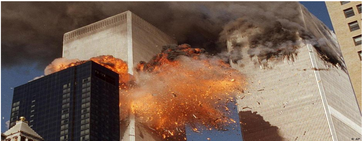
FIGURA 4 – COLAPSO TIPO PANCAKE
