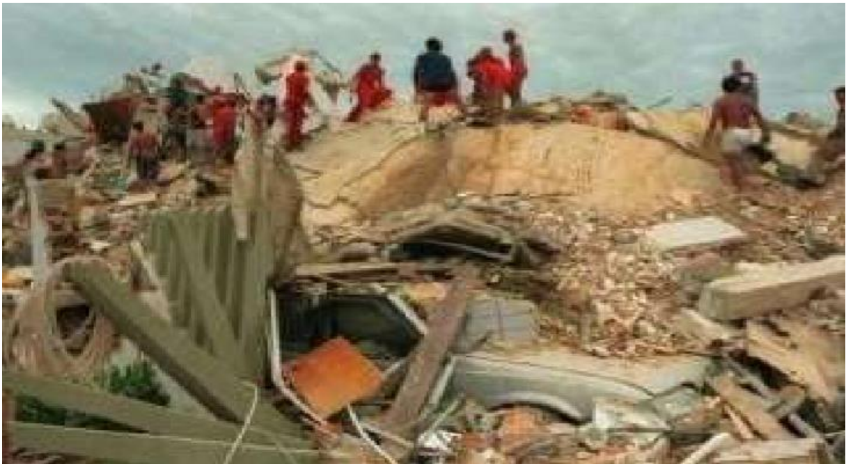
FIGURA 9 – EDIFÍCIO ATLÂNTICO APÓS O DESABAMENTO
