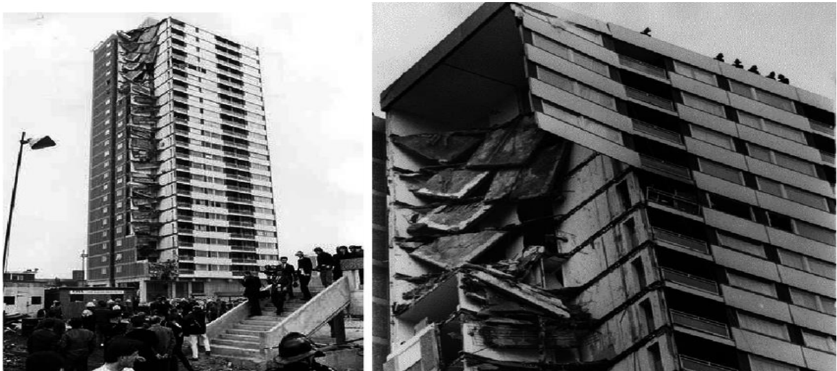
FIGURA 2 – COLAPSO PROGRESSIVO
