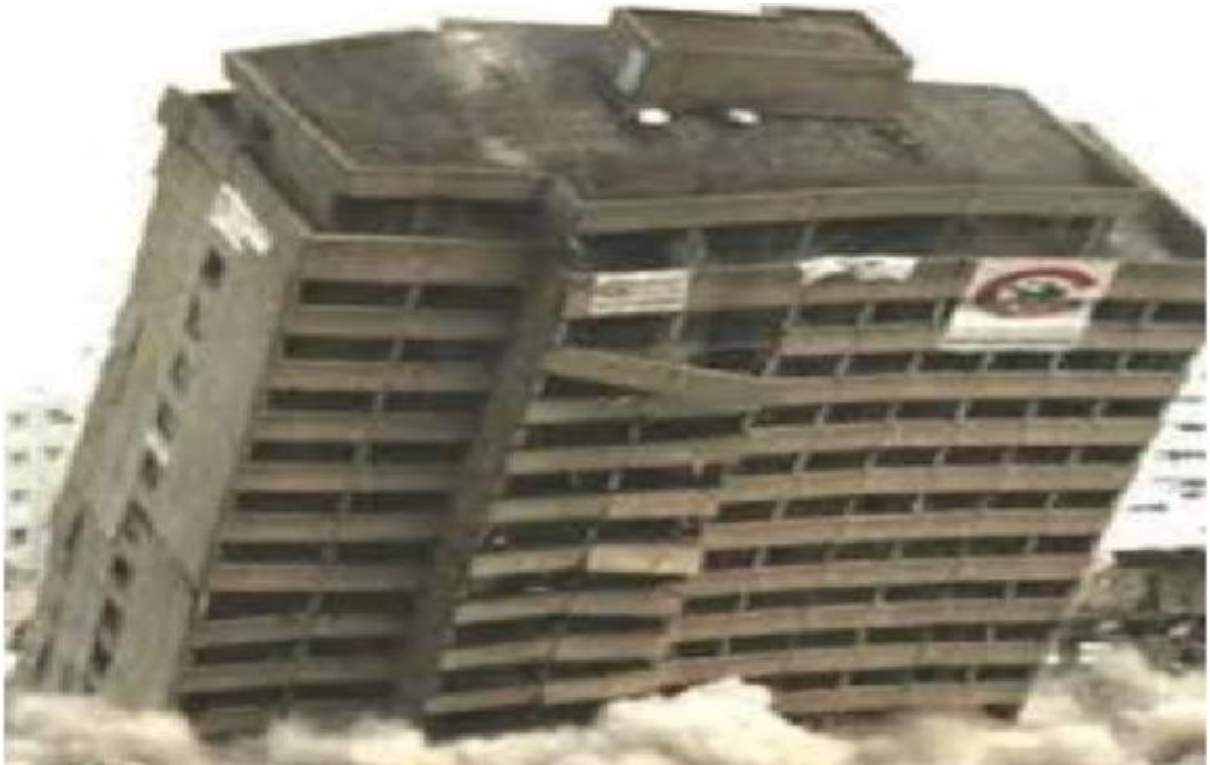
FIGURA 7 – COLAPSO TIPO INSTABILIDADE
