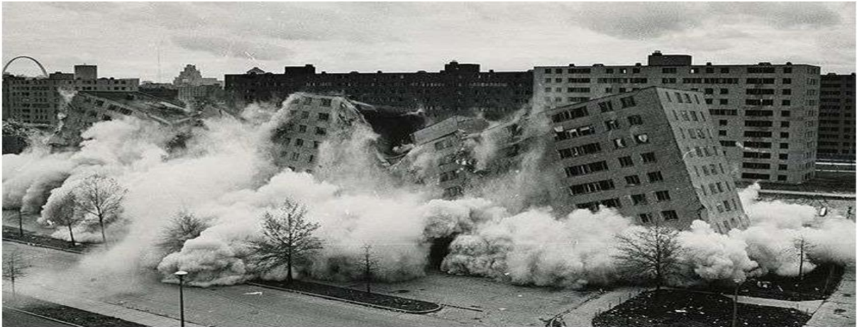
FIGURA 3 – COLAPSO TIPO DOMINÓ
