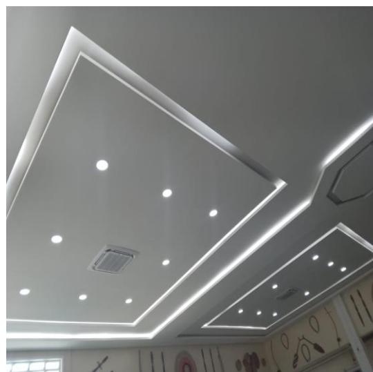
Climatização da praça de alimentação
